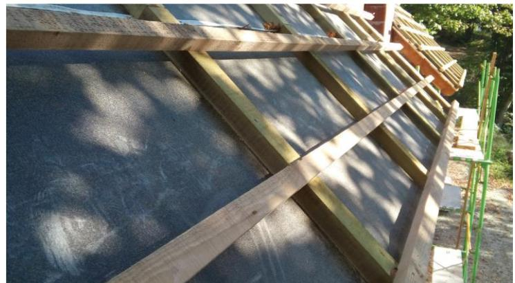
Bitumenske sekundarne obloge omogućuju pravilnu i kvalitetnu izvedbu kosih krovova, a odlikuju se i dugim vijekom trajanja.
