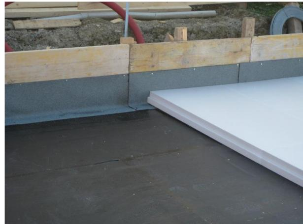
Umjesto klasičnih trakastih temelja imamo betonsku ploču koja se oslanja na kontinuirani toplinski izolacijski sloj od XPS ploča visoke nosivosti, tzv. temeljni jastuci, a može se ugraditi i hidroizolacija između donjeg i gornjeg sloja toplinske izolacije ili na temeljnog betonu, ovisno o odabranom sustavu. U ovom radu predstavljamo dva derivata Hidroproof self i Hidroproof radon.
